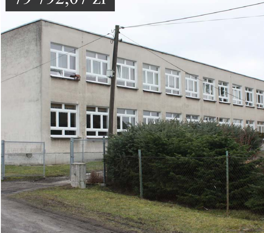
PSP Koniewo Wykonano remont połączeń dachowej
